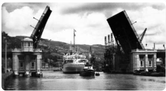
El puente levadizo de Deusto en reparación.
