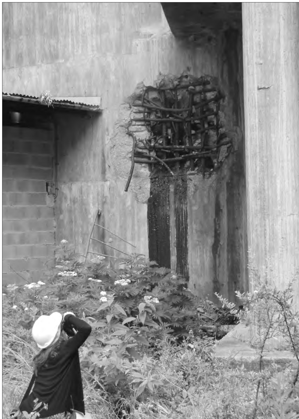
Azaleko argazkia Lemoizko zentralaren erreaktore baten kontenedoreko horman egindako zauria-rena da, 2013ko gure "bigarren txangoan" ateratakoa. Kontatu zigutenez, dinamitaz erresistentzi proba bat egin zioten eta bertan utzi gerora (argazkia: Juan Gorostidi).
